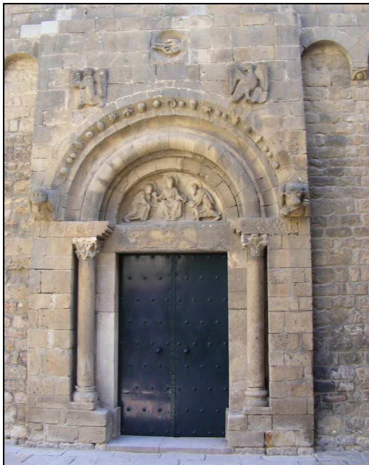
Fig. 10.- Detalls dels elements decoratius que constitueixen el portal d'entrada al temple de Sant Pau del Camp. On destaquen els capitells i les impostes d'època visigòtica.
