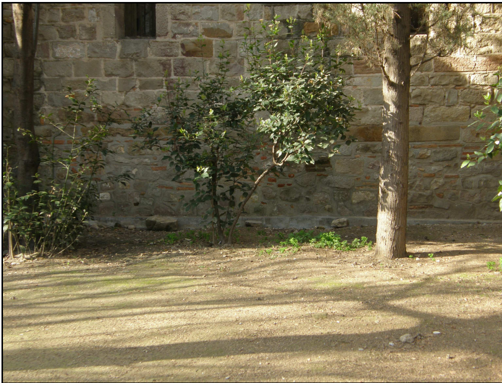
Fig. 21.- Àrea on es va decidir realitzar el Sondeig per localitzar el murs afectats per la rasa realitzada al 2007.
