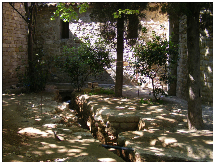
Fig. 71.- Vista general de la zona de la intervenció de la Segona Fase.
