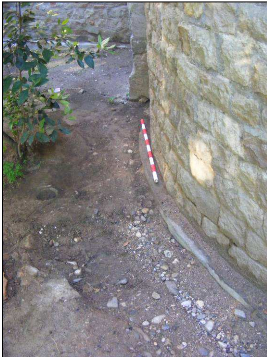
Fig. 84.- Vista inicial de l'àrea a intervenir.
