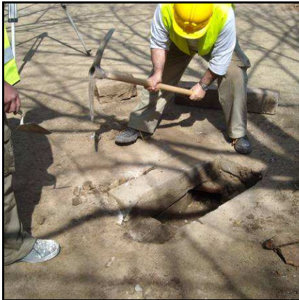
Fig. 19.- Obertura de l'embornal situat a prop de la Rasa U.E. 1000, per tal d'identificar la direcció del tub instal·lat a l'any 2007.
